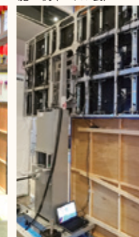
施工例(パネル裏)
